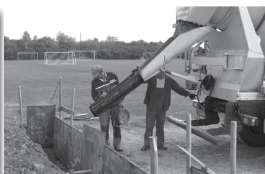
BETONLIEFERUNG FÜR DIE FUNDAMENTE
