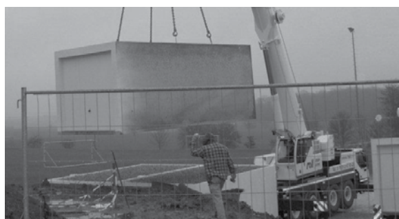
VERSETZEN DER OBEREN GARAGEN PER KRAN
