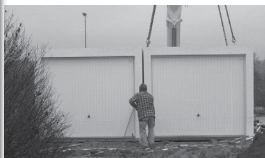
OBERE GARAGEN AN ORT UND STELLE
