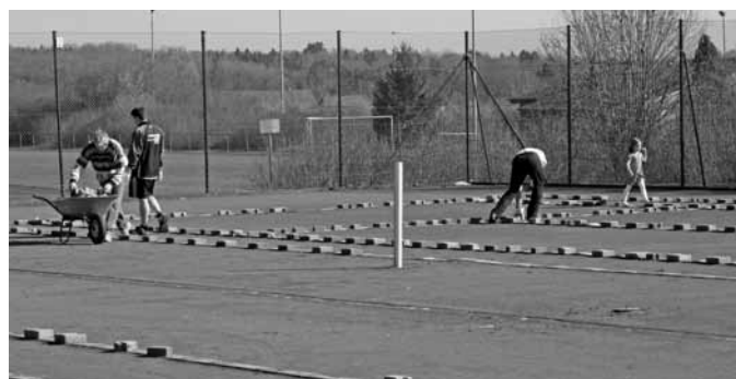
DIE JÄHRLICHE FRÜHJAHRSEINSTANDSETZUNG
