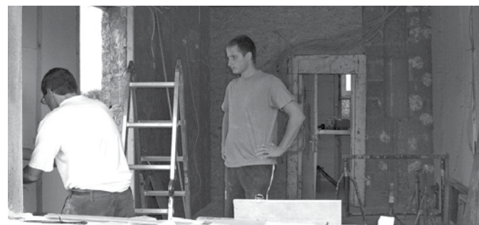
AUSBAU ALTER GERÄTERAUM ZUR GRILLSTATION
